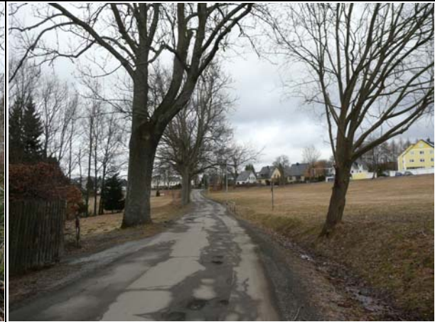
Abb. 9: Lönsweg, Blick nach Norden
