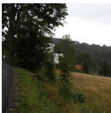
Abbildung 15: Baulücke Hüttengrundstraße, Blick auf westliche Bebauung.
