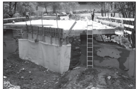
Abschluss des Brückenbaus im Pöhlatal
