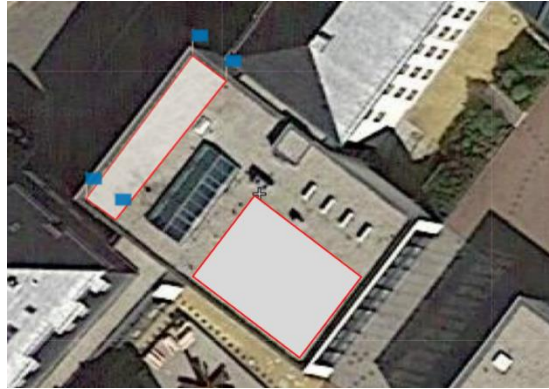
Abbildung 18: Dachfläche Bildungszentrum Adam Ries
