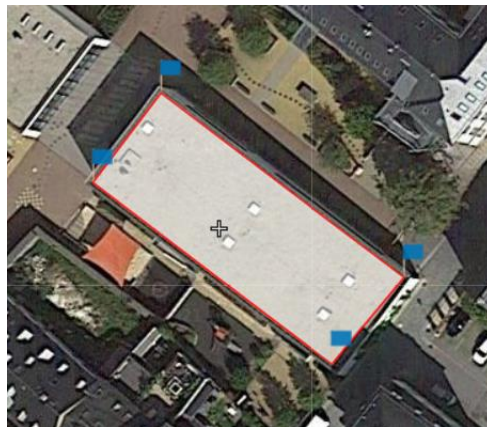
Abbildung 19: Dachfläche 2 Bildungszentrum Adam Ries
