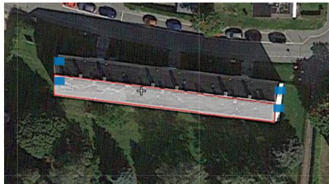
Abbildung 14: Dachfläche Straße der Jugend 2, 4, 6
