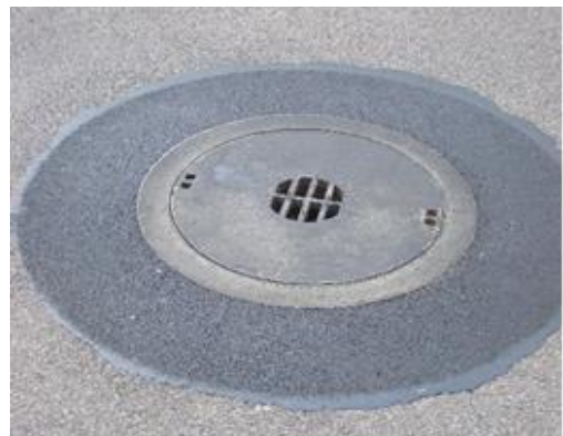
Fotos: Granitkleinpflaster in der Fahrbahn mit erhöhter Lärmemission und Gussasphalt-Schachtabdeckung mit niedriger Lärmemission
