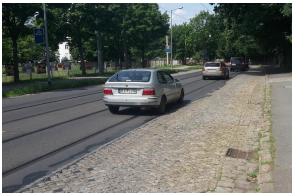
Fotos: Granitkleinpflaster in der Fahrbahn mit erhöhter Lärmemission und Gussasphalt-Schachtabdeckung mit niedriger Lärmemission
