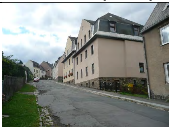
Buchenstraße mit angrenzender Bebauung
