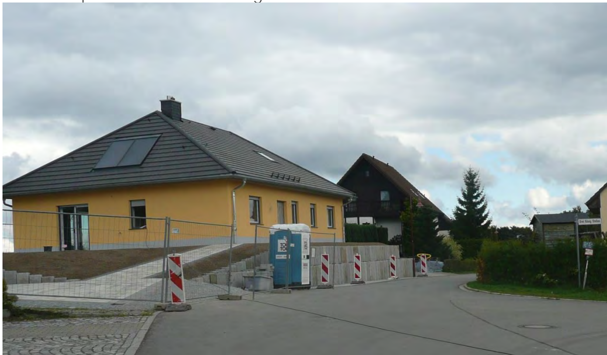
Abb. 9 Beispiel Stützmauer aus Plangebiet
