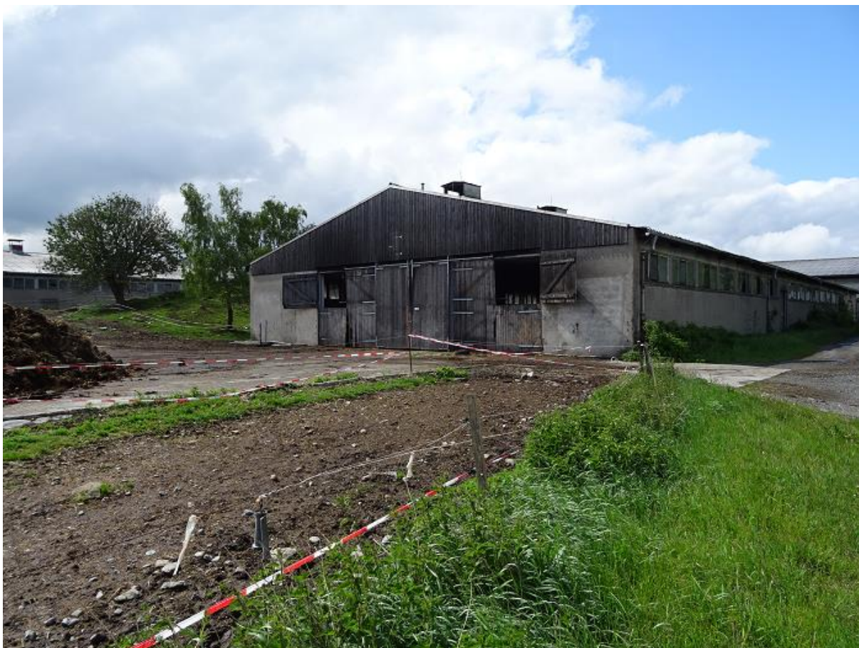
Foto 11: Blick von Nordost auf die abzubrechenden Stallanlagen, 26.05.2020.
