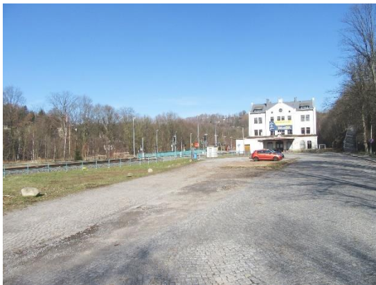
Foto: Bahnhofsvorplatz Unterer Bahnhof vor dem Umbau
