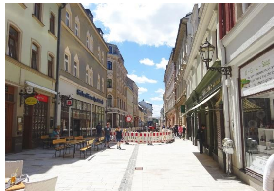
Foto: Bespielung und Baustelle Buchholzer Straße
