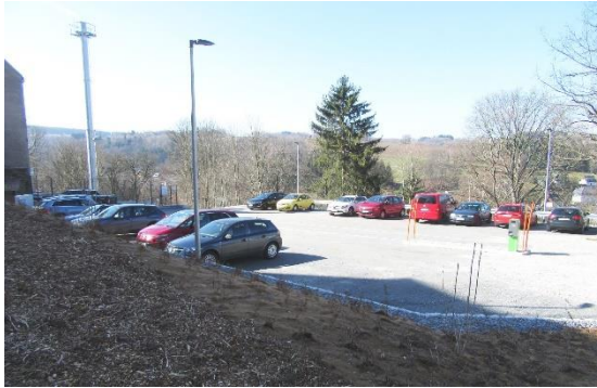
Foto: neu errichtete Parkfläche Benediktplatz
