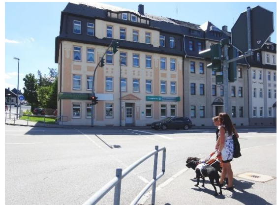
Foto: Furt am Knotenpunkt B 95/ B 101 ohne taktile Elemente, nur zwei Furten mit akustischem Signalgeber
