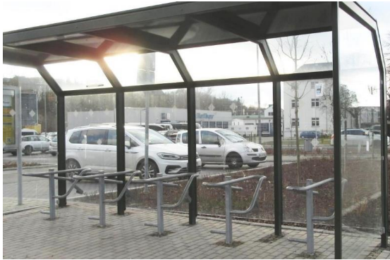
Foto: Beispiel überdachte Abstellbügel, Bahnhof Mitte in Plauen
