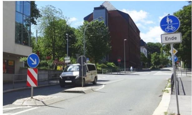
Foto: Querungshilfe B 101 Adam-Ries-StraÙe, deutlich untermäÙig und v.a. für querende Radfahrer im Zuge der vorgesehen Radführung zu kurz
