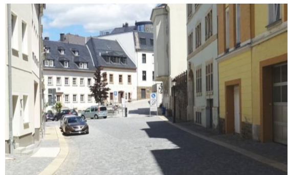
Foto: neu gebauter, schmaler Gehweg trotz ausreichend Raum, Karlsplatz
