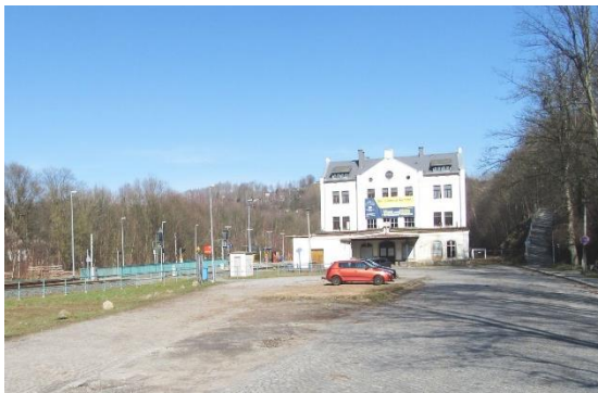
Foto: Bahnhofplatz Unterer Bahnhof (2020)
