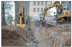
den bereits die Gründungspfähle der untersten Ebene hergestellt und der dazugehörige Pfahlkopfbalken aus Stahlbeton hergestellt. Außerdem ist der zwischenzeitlich notwendige Verbau wieder entfernt worden. Damit können die Bohrarbeiten für die weitere Bohrpfahlgründung des Parkhauses fortgeführt werden (Fotos).
